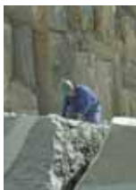
Titelbild — en couverture — in copertina Fernando Jorge Ferreira Pinto bei Sprengarbeiten im Steinbruch der Conrad AG in Andeer GR. Fernando Jorge Ferreira Pinto travaille à l'explosif dans la carrière de Conrad AG, Andeer (GR). Fernando Jorge Ferreira Pinto piazza l'esplosivo nella cava della Conrad AG a Andeer (GR).
