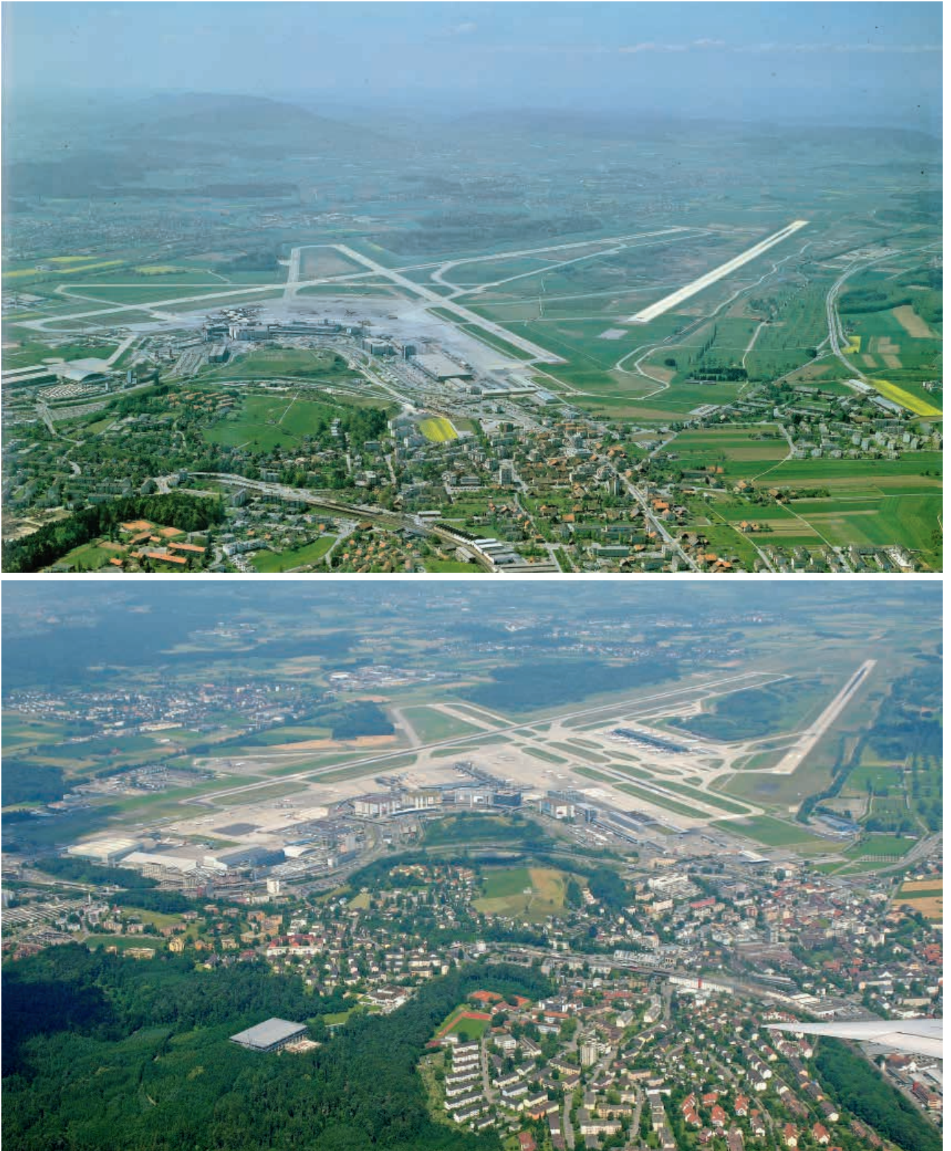
Abb.7 Kloten ZH 1976 und 2009: Der Blick aus Osten auf Kloten und das Flughafenareal zeigt aus unterschiedlicher Distanz die Entwicklung der Flughafeninfrastrukturen und des Siedlungsgebietes von Kloten, so etwa auch die Sportanlagen oder die Eishalle im Schluefweg (im Waldeinschnitt). Quellen: ETH-Bibliothek Zürich, Bildarchiv/Jules Vogt; M. Burger, Weggis
