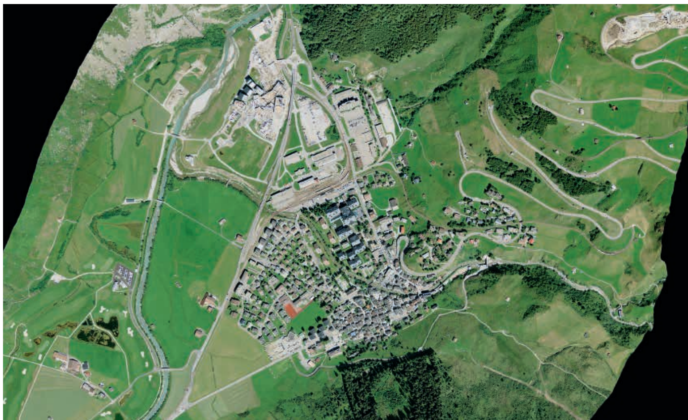
III.27 Andermatt (UR) en 2004 et en 2016: au sud de la gare (au centre de la photo) s'est établi l'hôtel Chedi. Entre la Reuss et la route principale, l'«Andermatt Swiss Alps Resort» est en construction, tandis que le terrain de golf à gauche de la Reuss (dans le bas de l'image) est déjà achevé. Source: swisstopo
