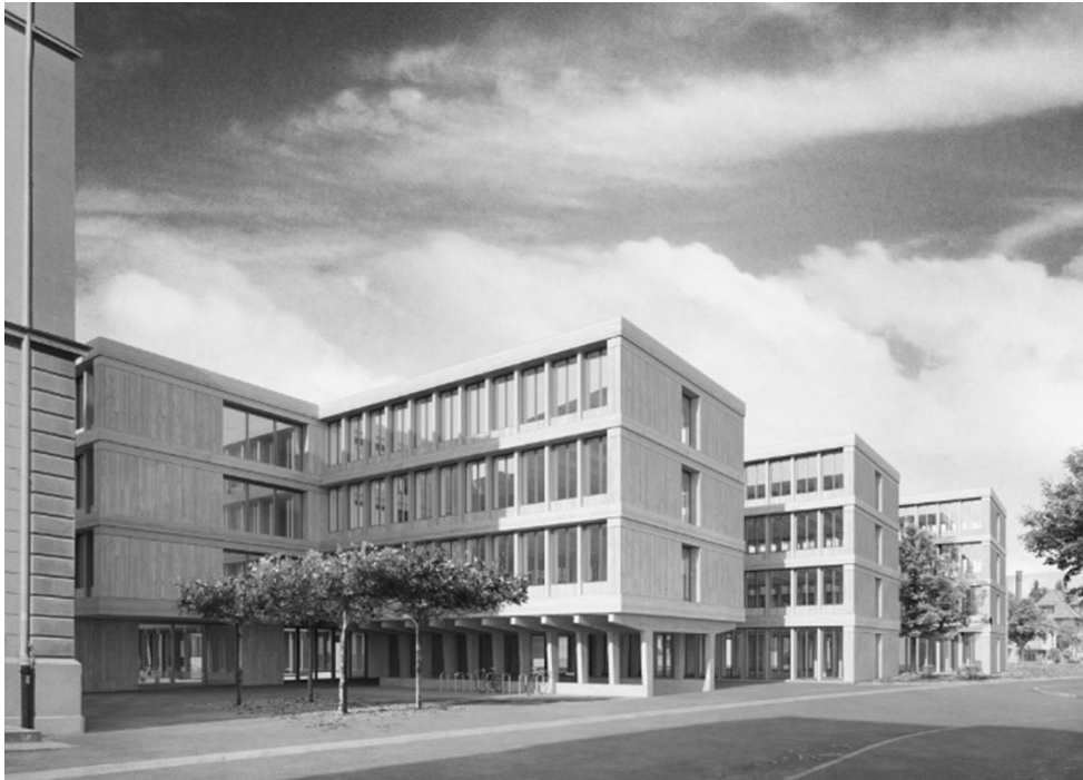
Bild: Ergänzungsbauten des Regierungsgebäudes im Thurgau, Quelle: www.glvd.ch
