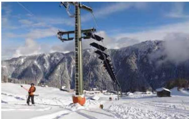
Der Solarskilift in Tenna gewinnt über die 82 an Tragseilen befestigten Solarflügel jährlich 90'000 kWh Strom.
