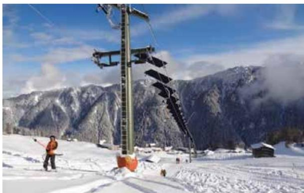
Le téléski solaire de Tenna comprend 82 panneaux solaires pour une production de 90'000 kWh ([www.skilift-tenna.ch](http://www.skilift-tenna.ch))
