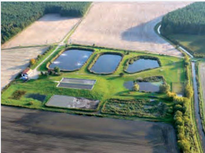
Teichkläranlage der Stadt Uebigau-Wahrenbrück, Ortsteil Winkel
