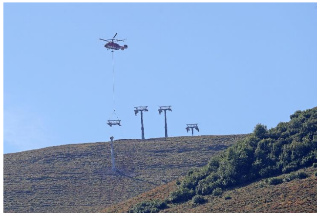
Abbildung 1: Montage der Masten der neuen Sesselbahn Foto: Ervin Monn
